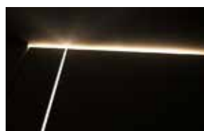
スリット幅はわずか 5mm 採光部 材質:樹脂
