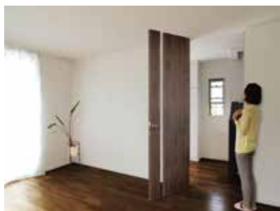
フルハイトドアの空間 (H2,400mm) 下がり壁がないことで、天井がつながり、お部屋に 広々とした開放感が生まれます。
