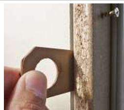
2mmのクリアランスを保ち調整ビスで取付
