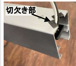
レールの配線用切欠きに 電源線とサブコードを通す
