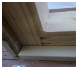
見切縁の取付け
