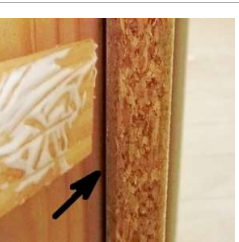
柱面からクサビ等が飛び出している
