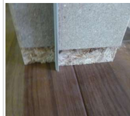
下地の幅木欠き込み部分 (7×30)
