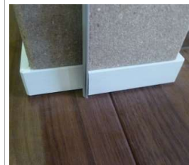
下地の欠き込み部分にはめ込むように取付け
