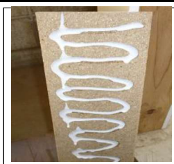
裏面に接着剤全面塗布 (推奨：酢ビ系)
