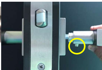
扉戸先木口面から見て右側のハンドルの六角ネジを締める
