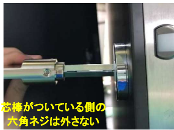
座の軸がある方を扉に挿し仕込む
