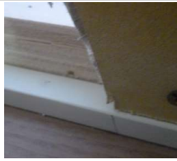
【準耐火納まりの場合】 入隅の場合は中方立下地は使用せず 石膏ボードを伸ばす
