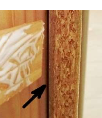
2mmのクリアランスを保ち調整ビスで取付
