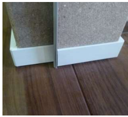
下地の欠き込み部分にはめ込むように取付け
