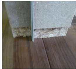
下地の幅木欠き込み部分 (7×30)
