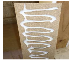
下地裏面に接着剤全面塗布
