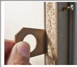
2mmのクリアランスを保ち調整ビスで取付
