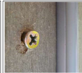
調整ビス頭の飛び出し ×
