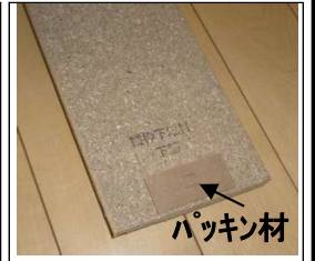
縦枠下地の下部裏側に2mm厚パッキン材取付済
